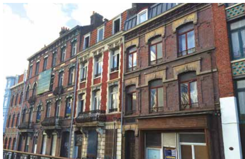
Les premiers immeubles concernés par l'opération de rénovation d'Action Logement sont ceux du quai de Mardyck, à quelques centaines de mètres de la gare.
